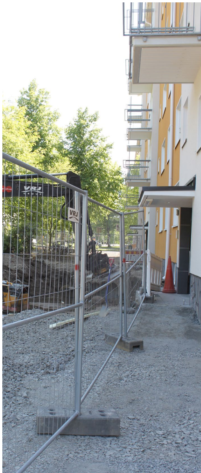
Työmaalla pitää olla asukkailla turvallinen kulunohjaus.
